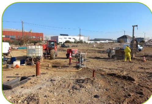
Injection par Direct Push
