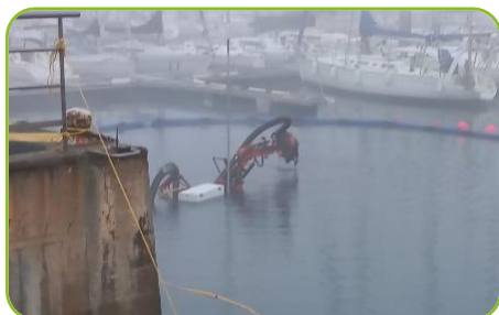
Dragage/pompage des sédiments
