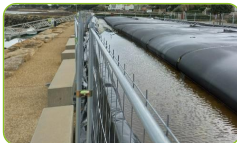
Déshydratation sur géotube
