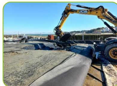
Reprise des matériaux déshydratés pour évacuation
