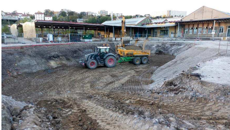
Phase de remblaiement
