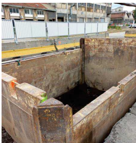
Blindage coulissant en place
