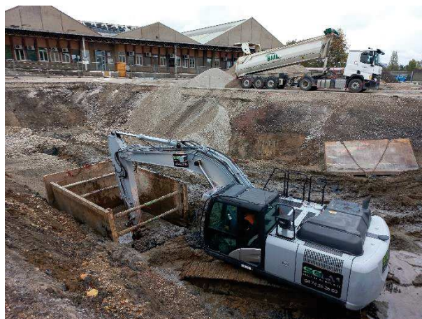
Excavation sous eau avec caisson blindage
