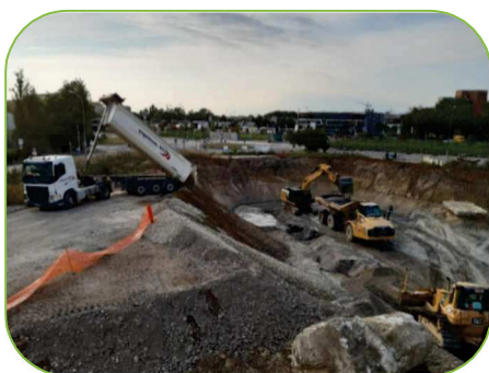
Terrassement et remblaiement à l'avancée
