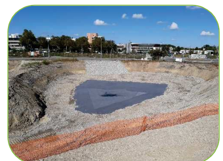
Pose d'un complexe étanche après remblaiement
