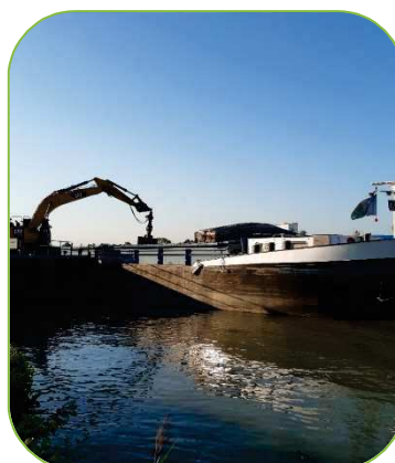
Evacuation des terres polluées par barge
